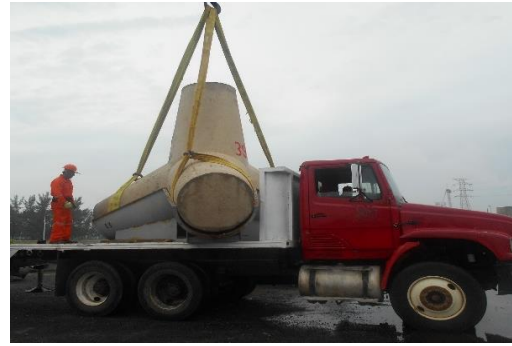
Figura 17 y 18. Aplicación de curacreto y traslado de los tetrápodos del patio de colados al patio de almacenamiento
