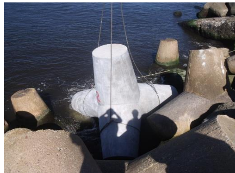
Figura 19 y 20. Traslado de los tetrápodos del patio de almacenamiento al lugar de la obra y colocación de los tetrápodos en el cuerpo de la escollera
