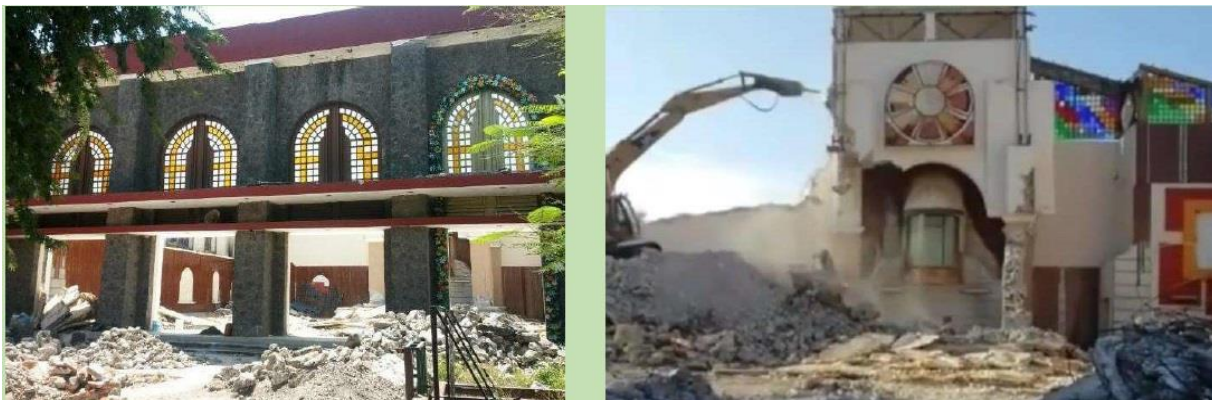
Figura 4. Demolición y remoción de escombros
