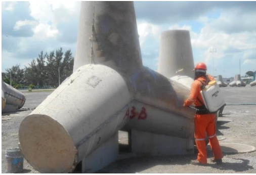
Figura 17 y 18. Aplicación de curacreto y traslado de los tetrápodos del patio de colados al patio de almacenamiento
