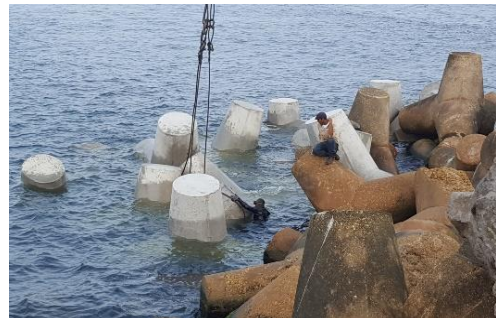
Figura 21 y 22. Colocación de los tetrápodos en el cuerpo de la escollera con apoyo de personal de buzo para la orientación de las piezas.
