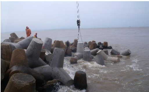
Figura 21 y 22. Colocación de los tetrápodos en el cuerpo de la escollera con apoyo de personal de buzo para la orientación de las piezas.
