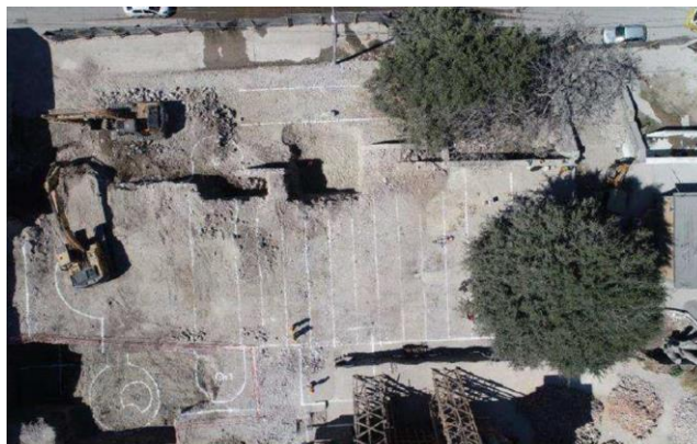
Figura 5. Excavación para desplante de la cimentación
