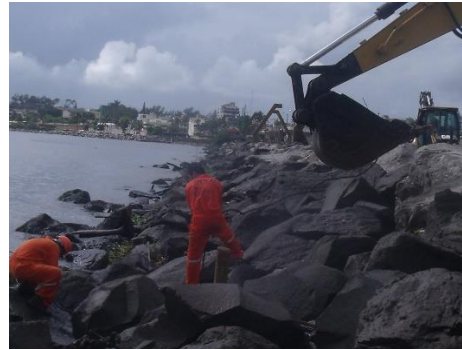
Figura 5 y 6. Reacomodo de roca deslizada sobre el talud del rompeolas
