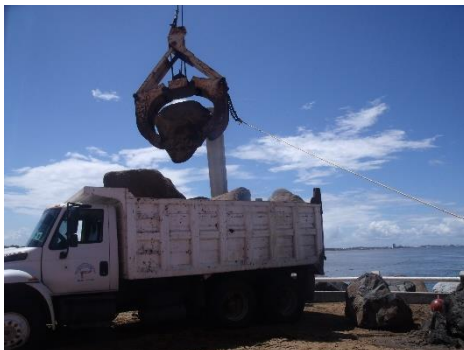
Figura 7 y 8. Remoción de roca y elementos prefabricados en zonas de proyecto.
