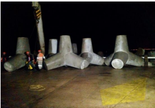
Figura 19 y 20. Traslado de los tetrápodos del patio de almacenamiento al lugar de la obra y colocación de los tetrápodos en el cuerpo de la escollera
