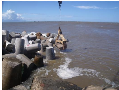
Figura 7 y 8. Remoción de roca y elementos prefabricados en zonas de proyecto.
