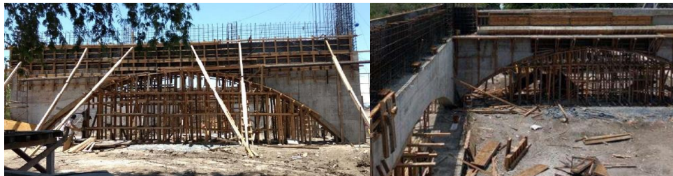
Figura 7. Muros de concreto
